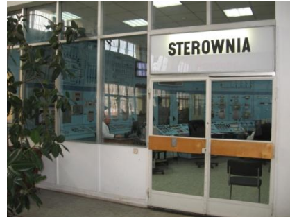
2. Widok na pomieszczenie mieszczące sterownię reaktora.
